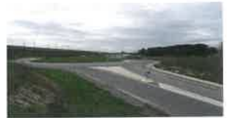
Arrivée par la RD 105 sur le nouveau giratoire de la RN 113
