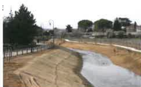
Travaux de renaturation de la Viredonne en amont du canal BRL
